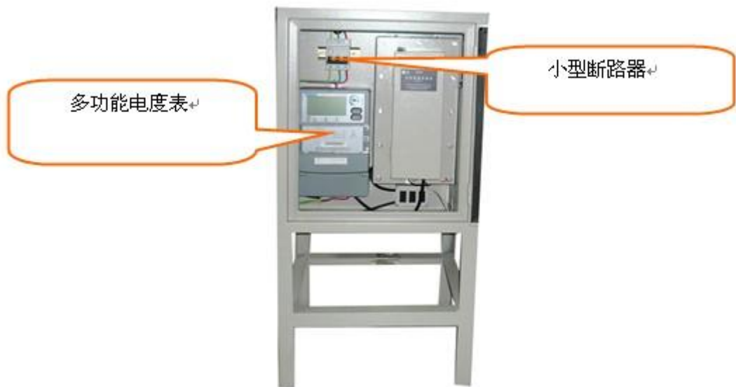
图 16 多功能电度表及小型断路器
